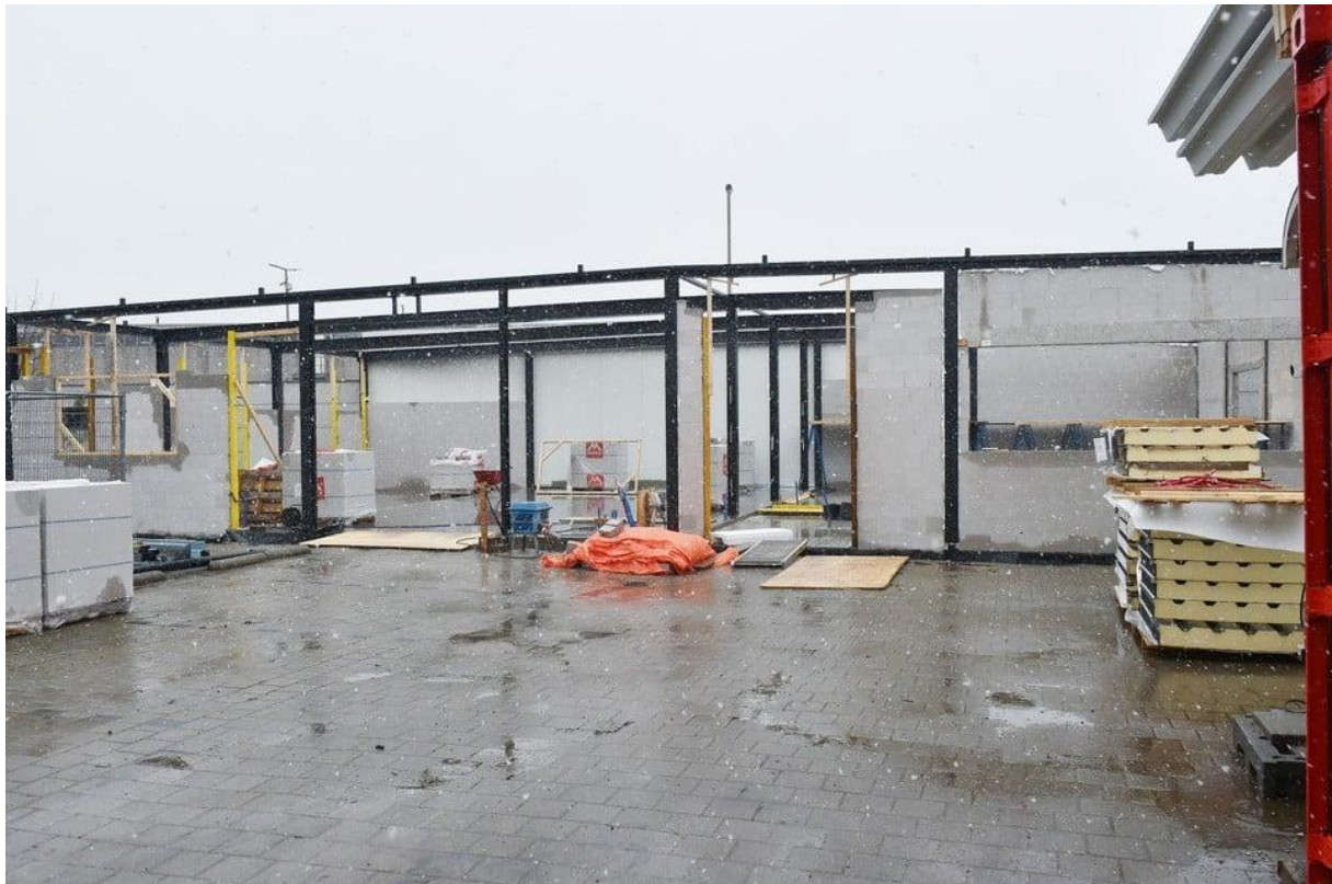
Op het terrein wordt hard aan nieuwbouw gewerkt. © Foto Ronald Goedheer
